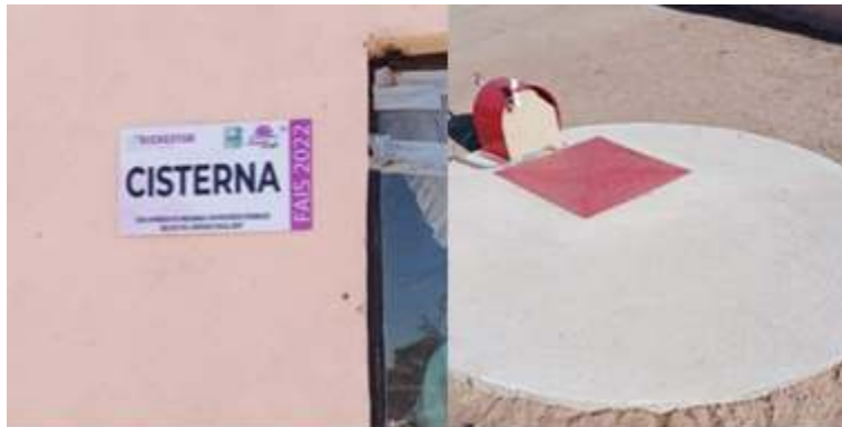
Construcción de cisterna
