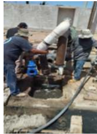
Desazolve de pozos de visita para prevenir derrames
