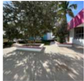
Término de obra
