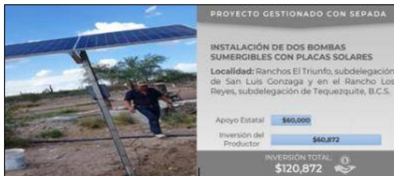
Instalación de equipo de bombeo con energía solar en el Rancho El Triunfo.
