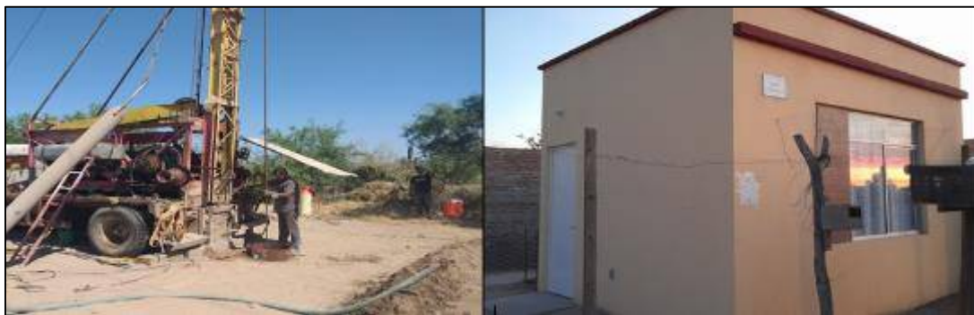
Supervisión de Obras del FAIS 2021.
