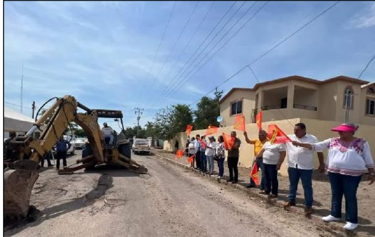
Inicio de obra FIS MDF.
