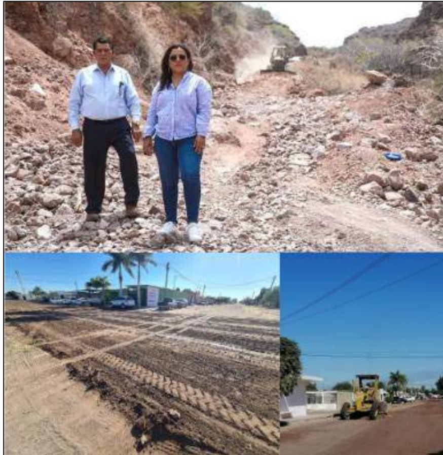
Trabajos de rehabilitación de caminos por parte del personal de Maquinaria Pesada y Conservación de Caminos.
