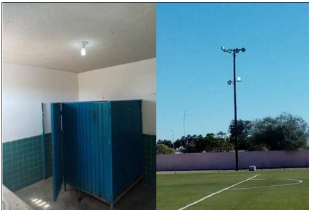
Trabajos de rehabilitación.
