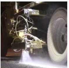
Se pintaron más de 8000 mts. Lineales en los carriles de la Avenida Forjadores
