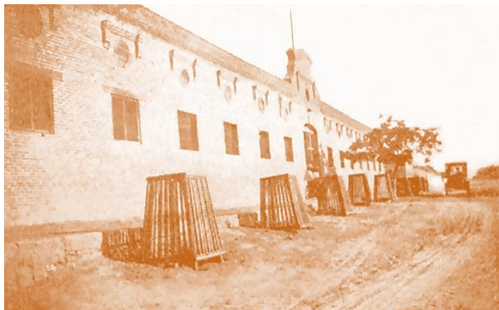
Antiguo Hospital Salvatierra, calle Segunda o Madero.
