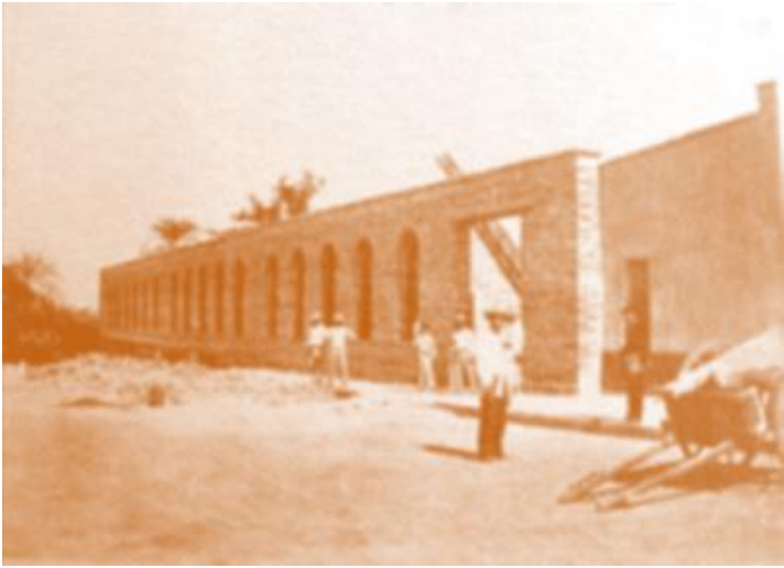
Construcción del edificio de la Gendarmería del Distrito
