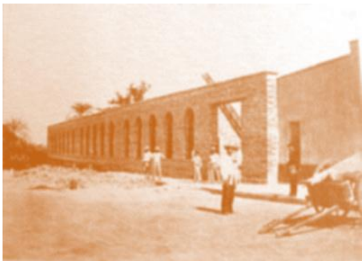
Construcción del edificio de la Gendarmería del Distrito
