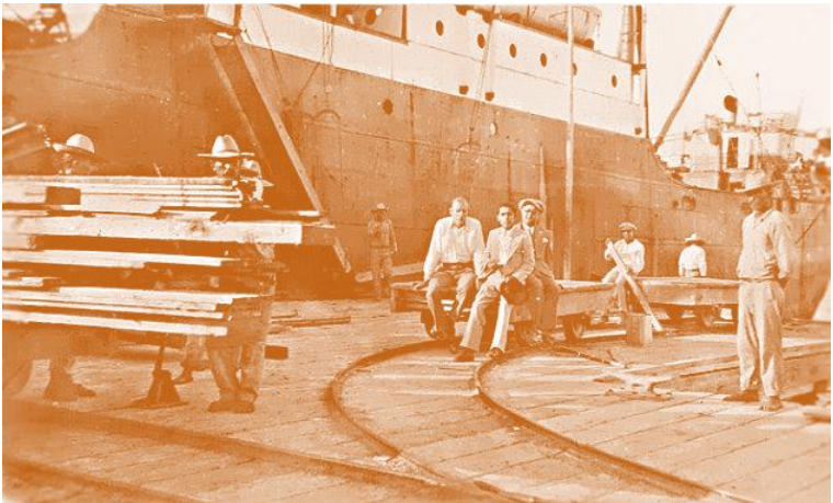
Movimiento comercial en el Muelle mostrando las vías para el tráfico de mercancías.
