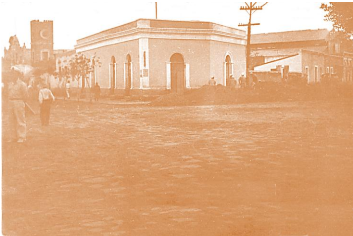
Antiguo edificio de Correos.
