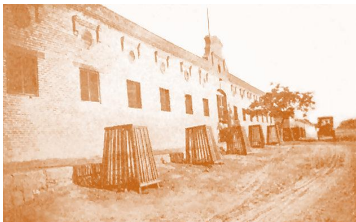
Antiguo Hospital Salvatierra, calle Segunda o Madero.
